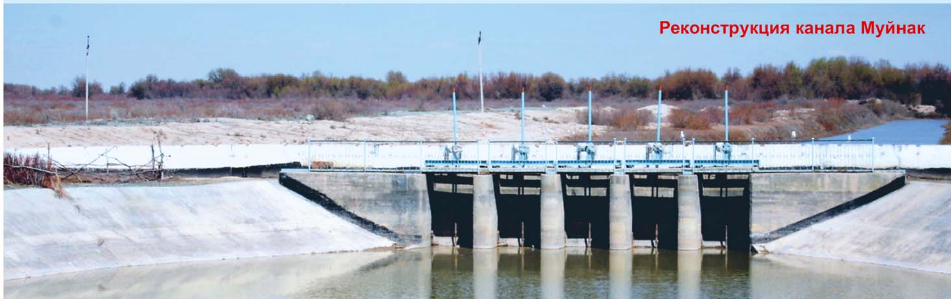
Головное сооружение канала Муйнак – Водозабор из Междуреченского водохранилища
