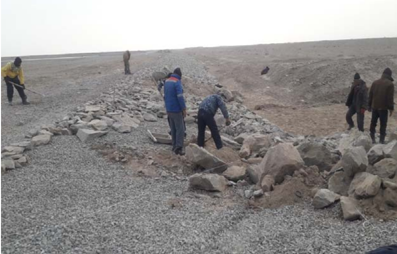
Реконструкция дамбы дороги вдоль озера Майпост
