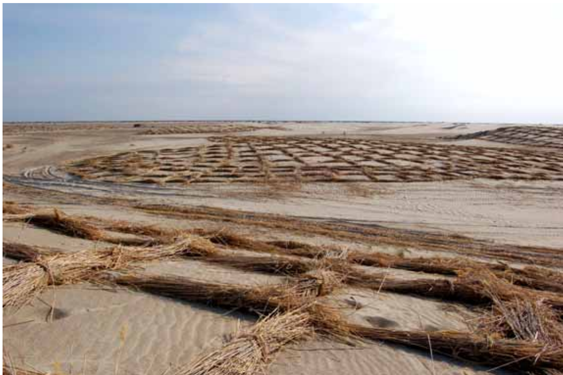
Рис. 53 Механическая фиксация песчаного покрова и дюн с помощью арундиарии гигантской
