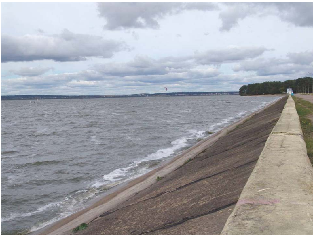
Рисунок 2 – Плотина Заславского водохранилища
