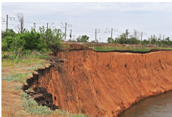
Рисунок 3 – Разрушение берега на р. Сакмары у с. Жёлтое (а). Берегозащитное сооружение на р. Урал у с. Облавка (б)
