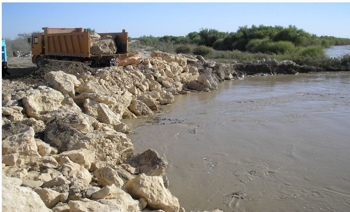
Рисунок 2 – Привлечение механизмов для восстановления размывшего участка дамбы (ПК 55+80)
