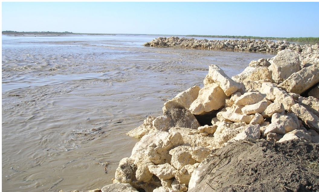
Рисунок 3 – Защита откоса защитной дамбы и устройство шпор (ПК 55+80)
