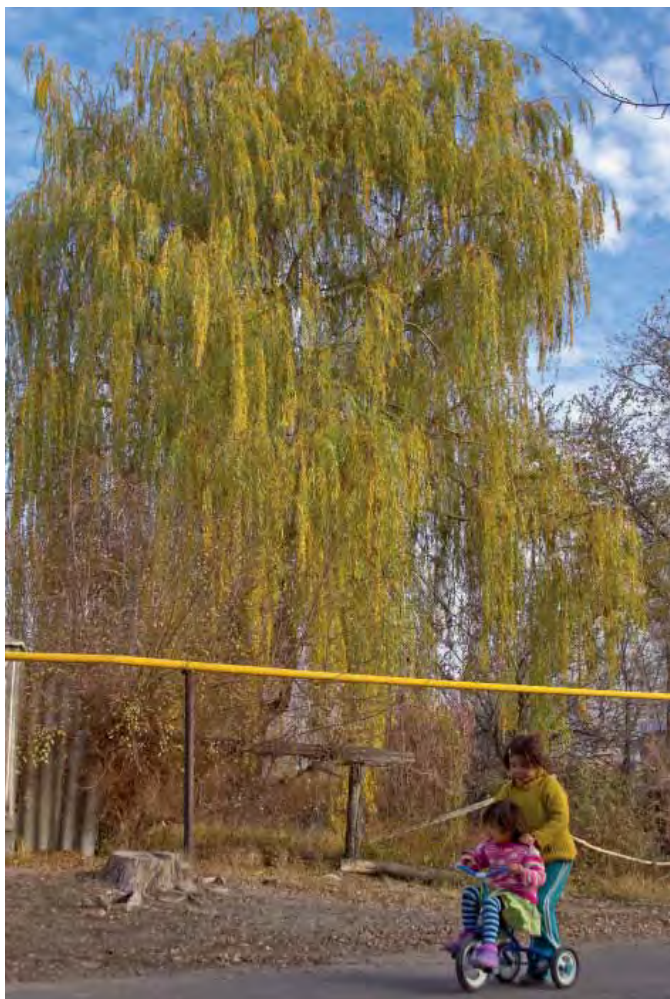
ПГТ Гранитогорск. Система газоснабжения жителей поселка.
