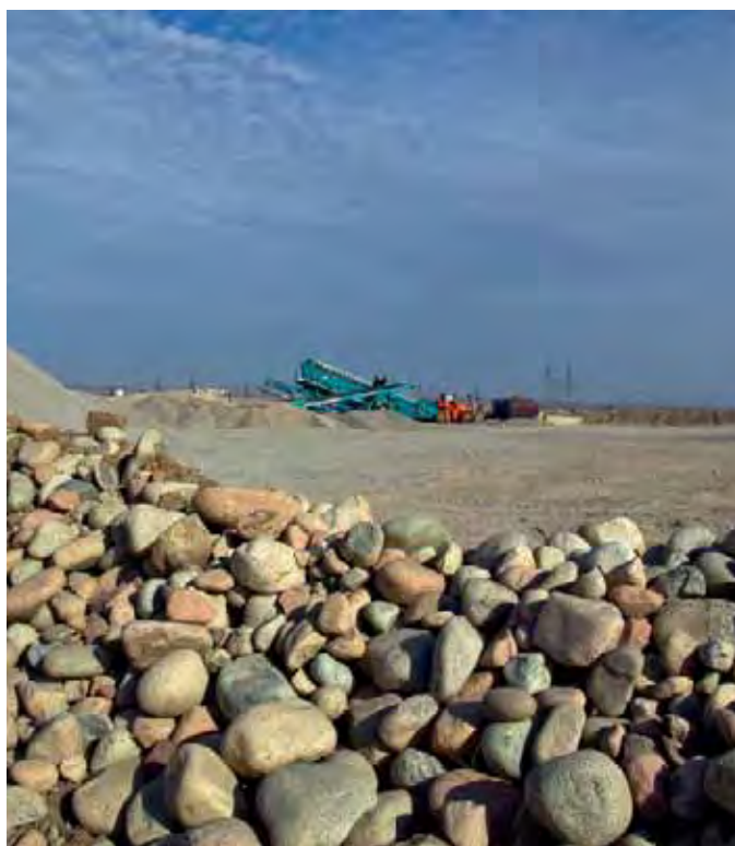
Строительство дороги Западная Европа-Западный Китай недалеко от бассейна реки Аспара.
