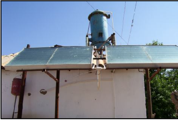
Рис.1. Солнечный водонагреватель для душа
