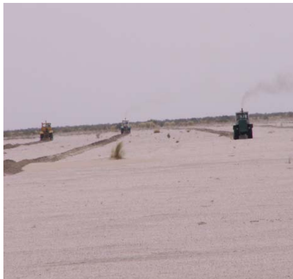
Рис. 2. Устройство песконакопительных борозд
