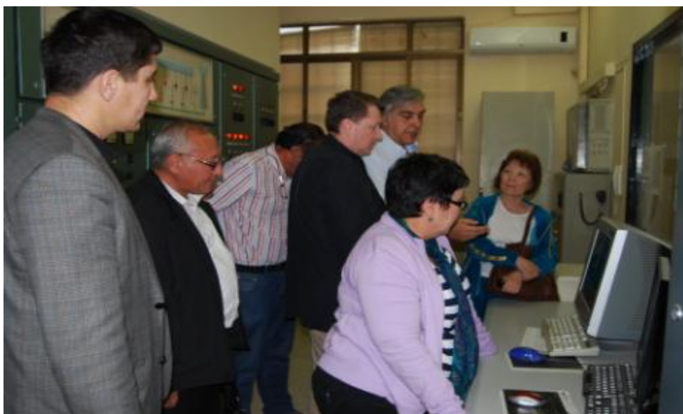
Участники поездки осматривают насосную станцию канала Зухар в провинции Бадахос в Испании (фото @ GIZ / Дженнифер Зеринг)
