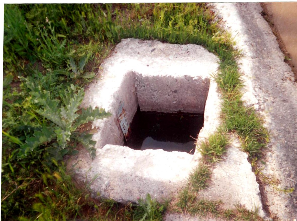
Водомерный колодец
