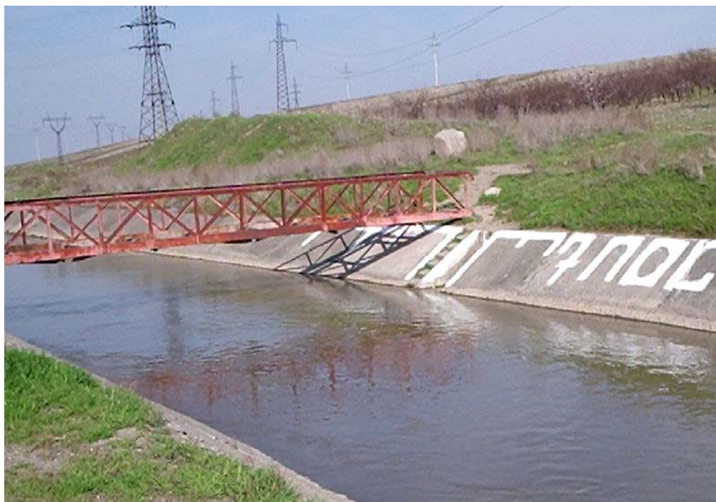
Гидропост на магистральном канале (ЮФМК)
