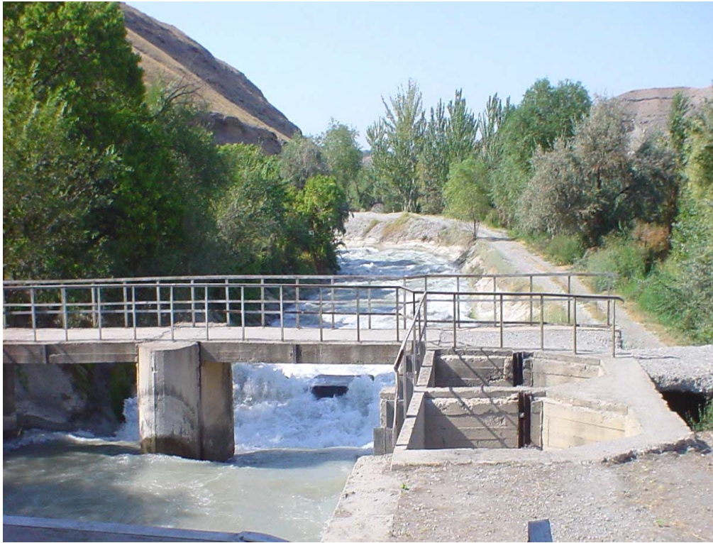
Головное сооружение ХБК
