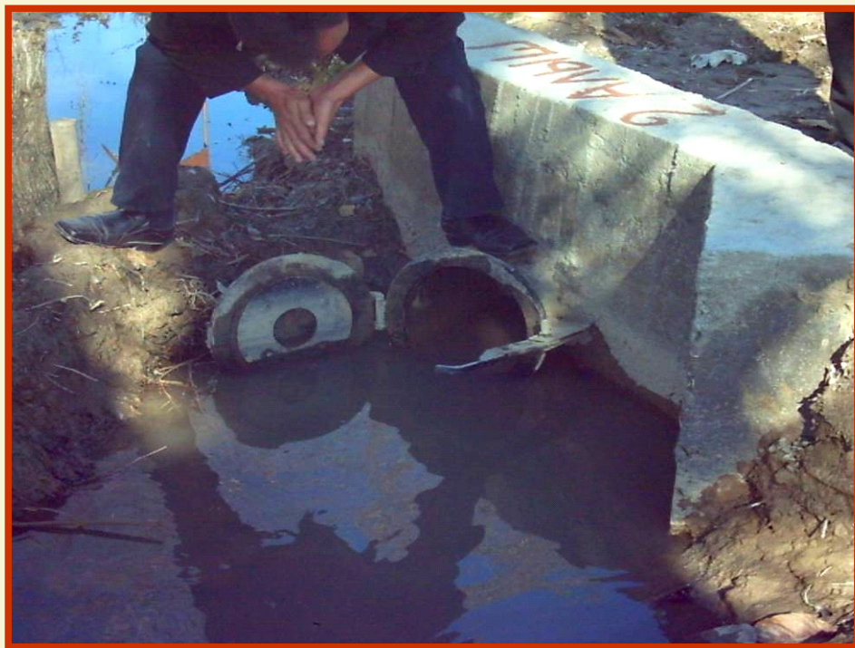
Рис. 7. Оснащение отводов ГВП водовыпускными сооружениями
