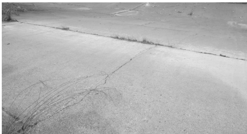
Рисунок 2 – Непрерывная продольная трещина, параллельная бровке канала, на втором участке, 2018 г.
