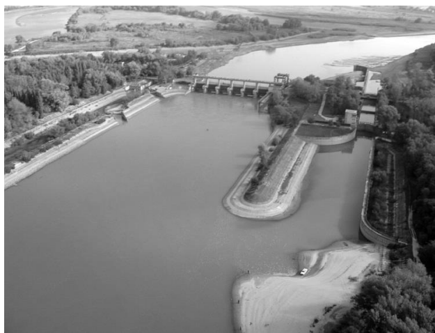
Рисунок 1 – Федоровский подпорный гидроузел (Краснодарский край)
