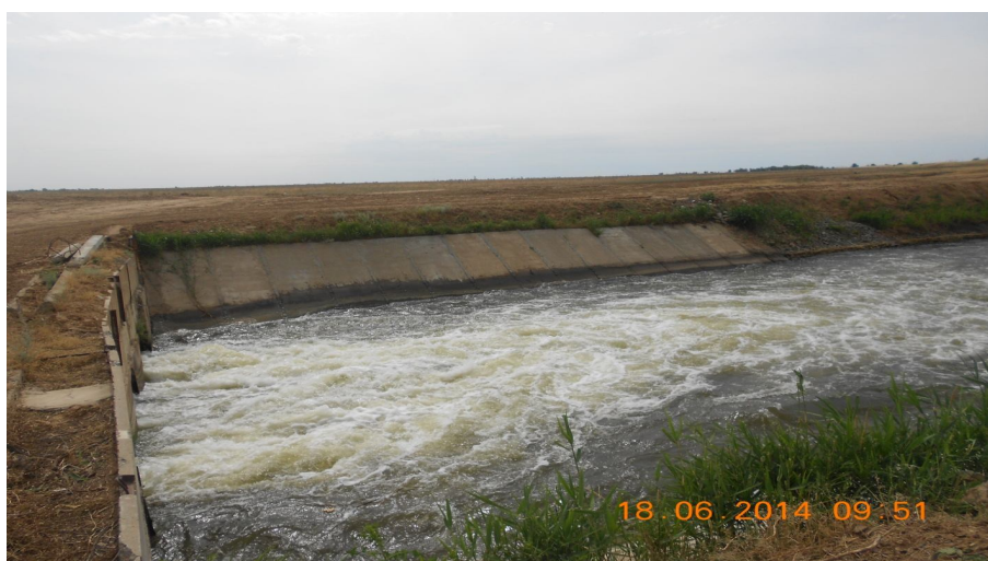
Рисунок 3 – Общий вид гидрометрического створа на ПК 243 + 80
