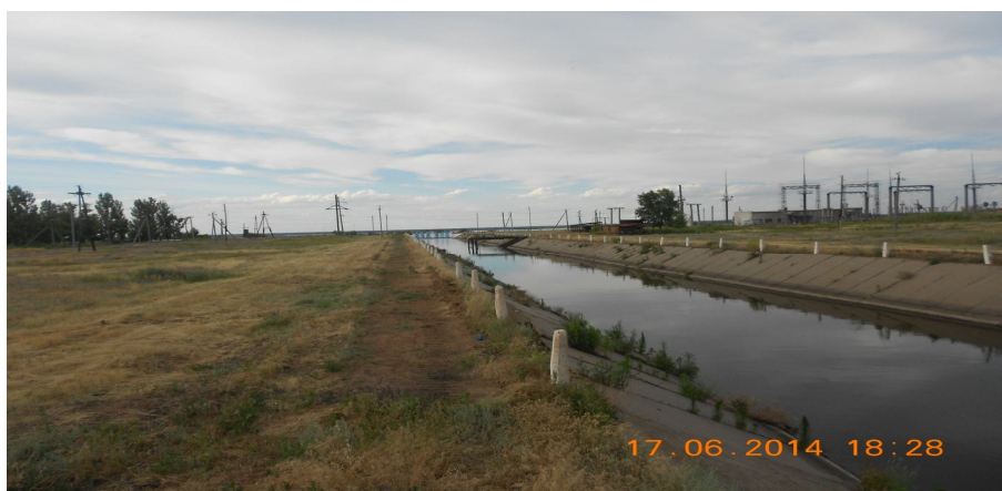
Рисунок 2 – Общий вид гидрометрического створа на ПК 243 + 80
