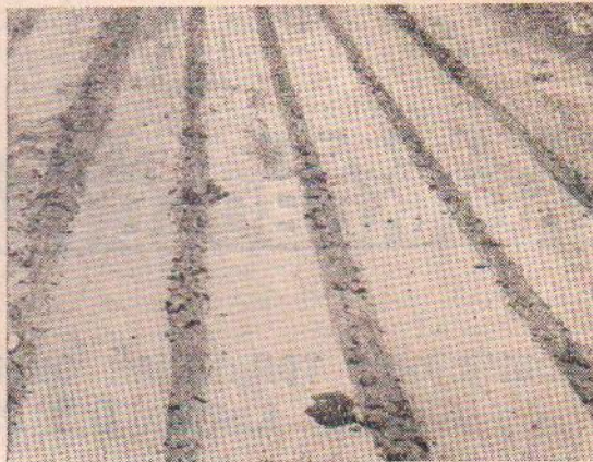
Рис. 4. Поверхность основания после прохода машины УМТС-2.
