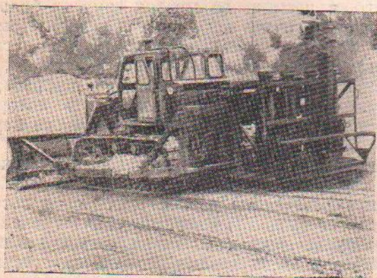
Рис. 2. Машина УМТС-2 на уплотнении естественного основания.
