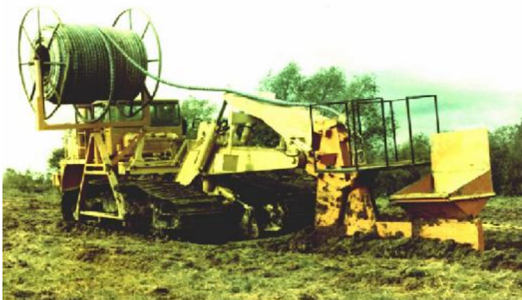
Рисунок 1 - Укладка дрены с фильтром из нетканого материала
