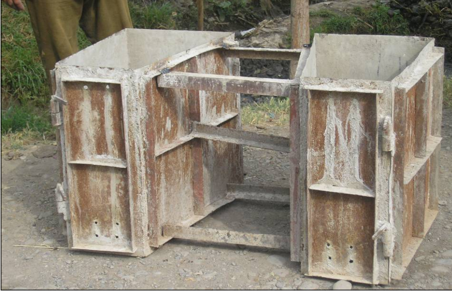
Переносная опалубка для изготовления (заливки бетоном) ВЛС на месте
