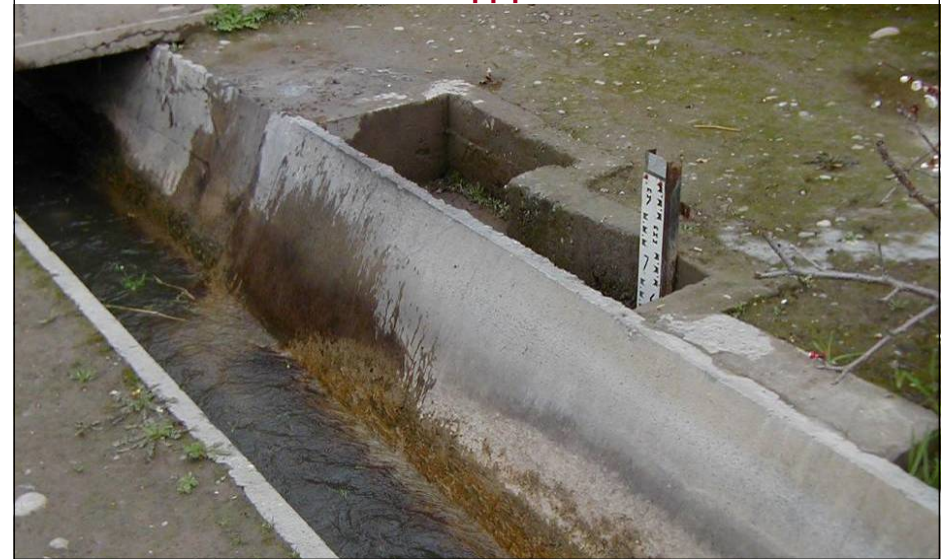
Гидрометрический пост типа «ФР» на параболическом лотке с уровнемерным колодцем
