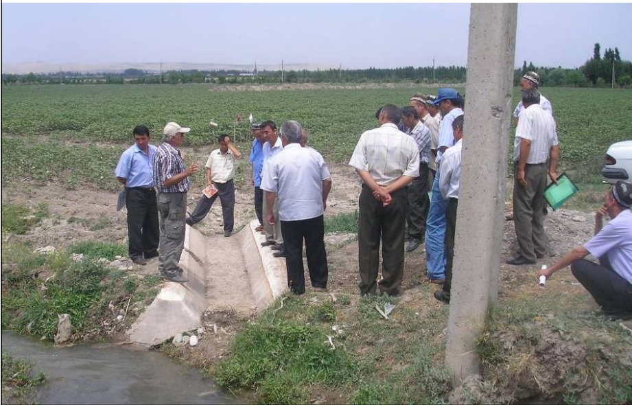
Гидрометрический пост типа «ФР»
