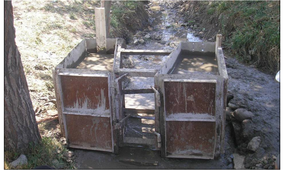
Заливка опалубки ВЛС бетоном на месте
