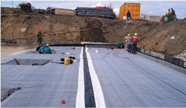
Рис.5. Укладка рулонов композита «Бетонное полотно Плюс» с HDPE геомембраной снизу. Проект в Румынии 2016 г
