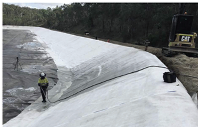
Рис.7. Укладка композита «Бетонное полотно» на склонах резервуаров для отстоя сточных вод, Cherbourg, Австралия, 2017 г
