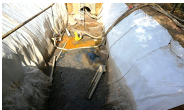
Рис.3. Укладка листов композита «Бетонное полотно». Проект в Люксембурге, 2017 г
