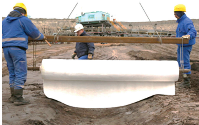
Рис.4. Укладка рулонов композита «Бетонное полотно». Проект в Германии, 2017 г
