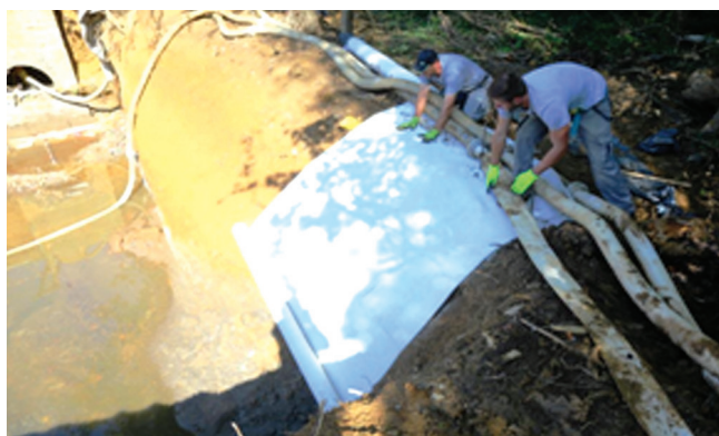
Рис.2. Внешний вид композита «Бетонное полотно Плюс» с HDPE геомембраной
