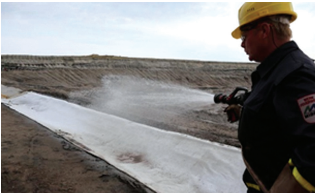
Рис. 6. Пропитка композита «Бетонное полотно» водой. Проект в Германии, 2017 г
