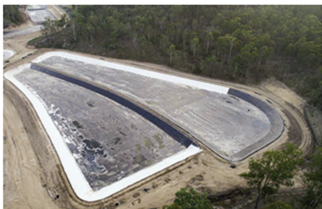
Рис.7. Укладка композита «Бетонное полотно» на склонах резервуаров для отстоя сточных вод, Cherbourg, Австралия, 2017 г
