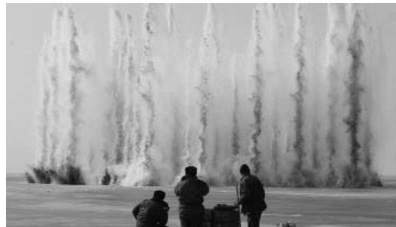
Рис. 2. Взрывные работы на льду Сев. Двины
