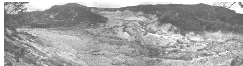
Рис. 1. Общий вид центральной части оползня 2007 г.
