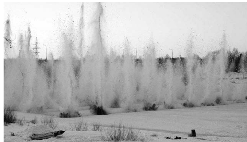
Рис. 3. Проведение взрывных работ на дне реки
