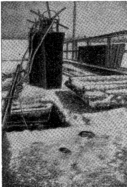
Рис. 170. Водяной реостат перед погружением в воду.
