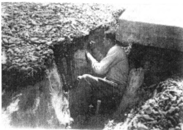
Рис.1. Сборные плиты с открытыми стыками, размер 2,5x4x0,25 м на сплошном обратном фильтре. Глубина размыва грунта в подплитной области около 80 см. Высота волн 3,2 м, расчетная 3,0 м.
