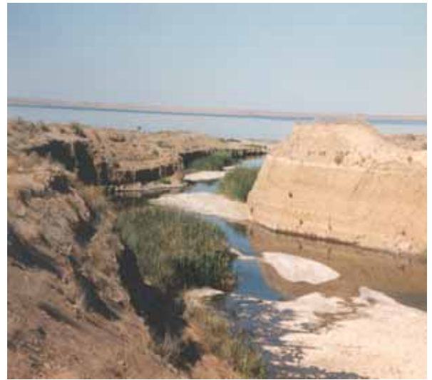
Воды коллектора Южного, периодически питающие оз.Сичанкуль, во время сбросов разработали довольно глубокий каньон, в котором видны остатки воды и выступившая на подсыхающем дне коллектора соль
